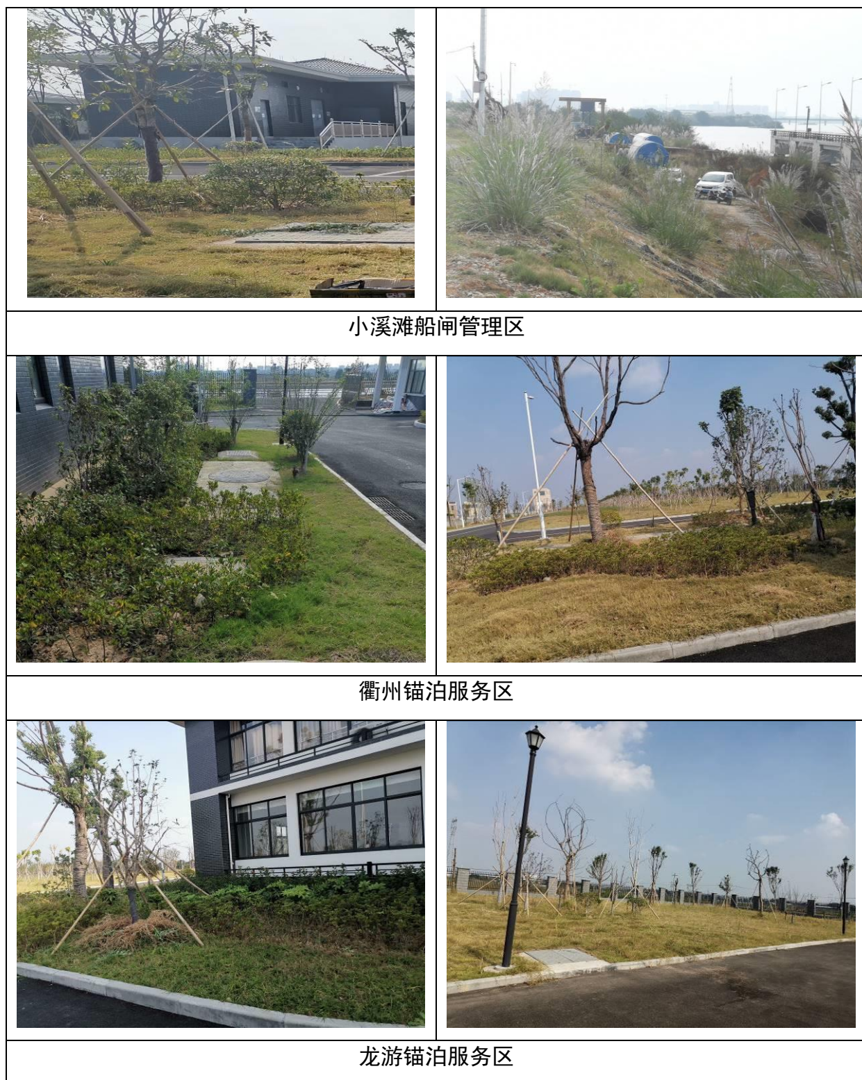
图 4.2-1 各船闸及锚泊服务区景观绿化现状图
